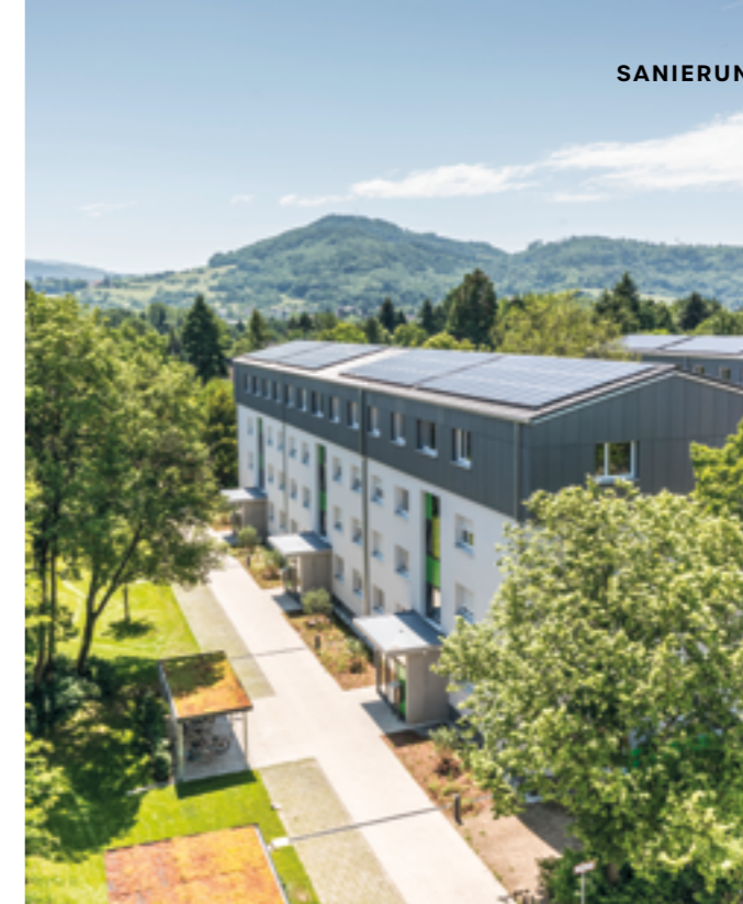
Jedes der sanierten Bestandsgebäude erhielt durch die Aufstockung sechs rund 78 Quadratmeter große 3-Zimmer-Wohnungen hinzu.
