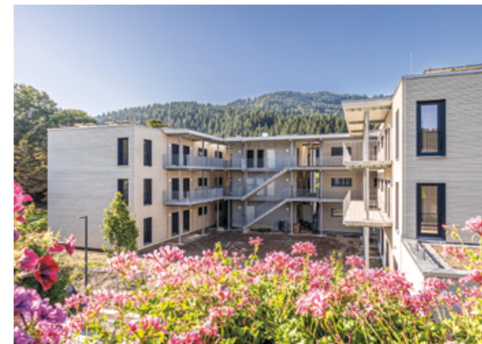
Eindrücke aus dem Sommer: Alles ist bereit für die Ausbaurbeiten und die Gestaltung der Außenanlagen.
