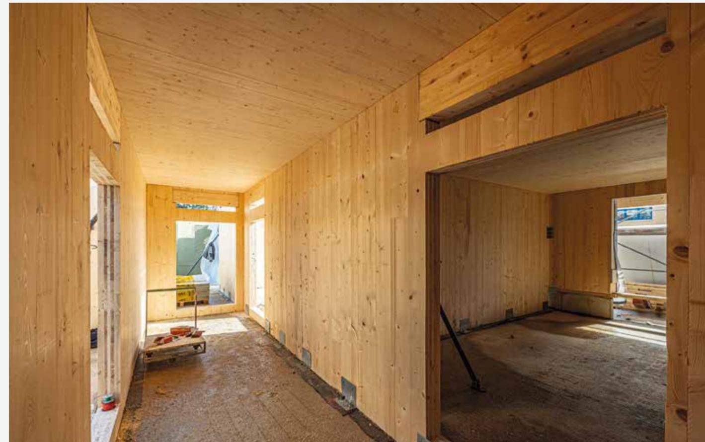
Tragwerk aus Brettsper Holz und Brettschichtholz
